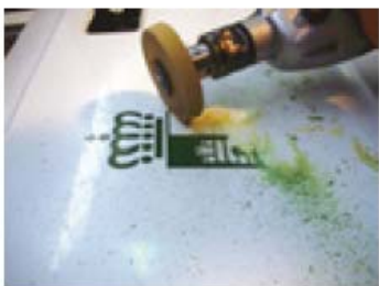
↑8.40. Irudia. Erraminta neumatikoa eta arrabola bereziarekin, biniloa kentzea
