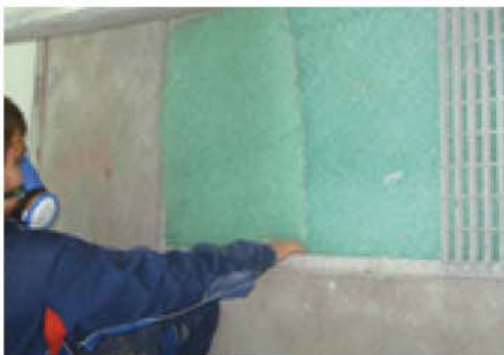
↑1.8.Irudia. Kabina-zangako burdin sarea eta paint stop iragazkiak
