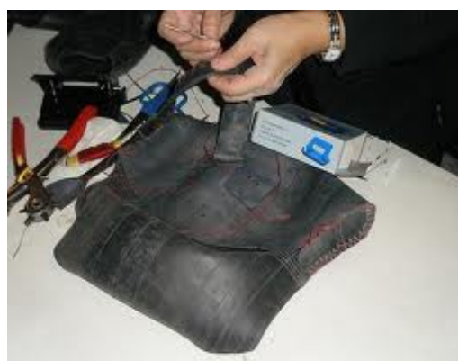
Fig. 16: Reparación de una cámara averiada
