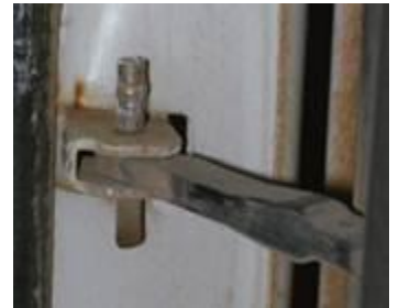
↑ 3.23 irudia. Pitzadurak eta oxidoa ateko bandan.
