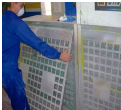
↑ 2.35 irudia. Xurgatze-planoko paint stop iragazkien desmuntaketa.
