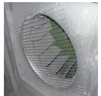
↑ 2.32 irudia. Xurgatze-planoko airea ateratzeko ekipamenduko hegatsak.
