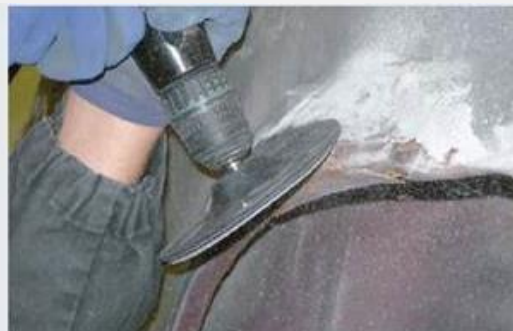
↑ 3.60 irudia. Korrosioa duen zonako oxidoa lixatzea.
