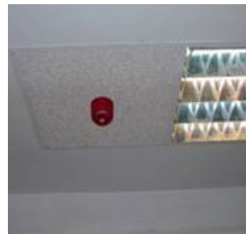
↑ 1.20 irudia. Pintura-boxeko ke-detektagailua.
