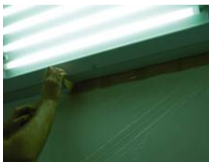
↑ 2.27 irudia. Kabinako hormak babesten dituen plastikoa aldatzea.
