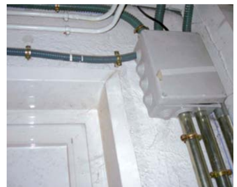
↑ 2.3 irudia. Kableak metalezko hodi bidez eta PVCzko hodi malgu bidez isolatuta daude.
