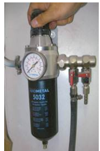
↑ 2.18 irudia. Airearen irteerako presioaren erregulazioa kabinako harguneetan.
