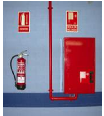
↑ 1.10 irudia. Sua itzaltzeko sistemak horman: su-itzalgailua eta sute-ahoa.
