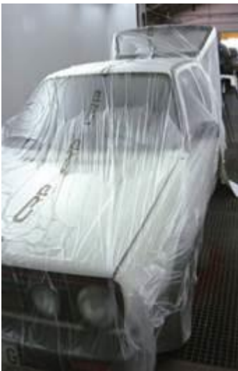
↑ 6.43 irudia. Plastikozko mihisearekin maskaratutako ibilgailua.
