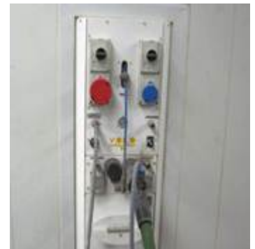
↑ 2.38 irudia. Xurgatze-sistema zentralizatuaren konexioak.
