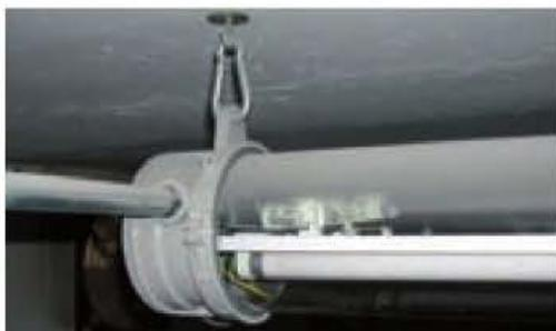
Figura 3.14. Sistema de iluminación con protección antideflagrante.
