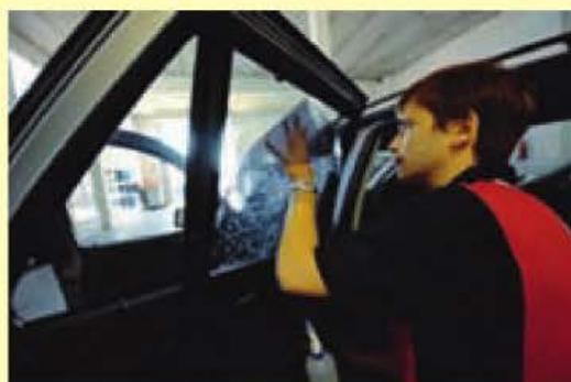
Figura 7.8. Colocación de la lámina en cristales laterales.
