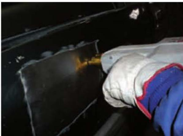
Figura 8.61. Soldadura de un elemento de tracción.
