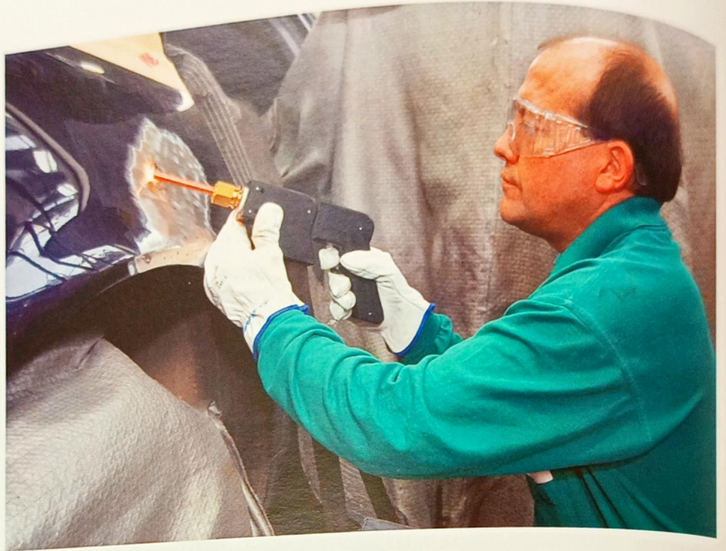
Recogida de chapa con electrodo de cobre
