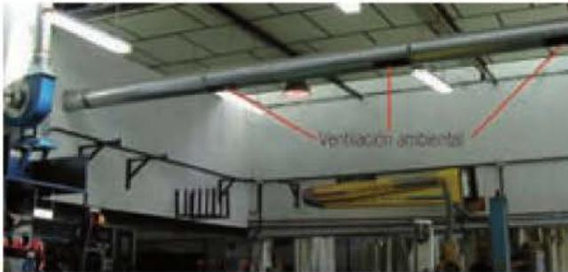
Figura 3.37. Sistema de ventilación dinámica o forzada.
