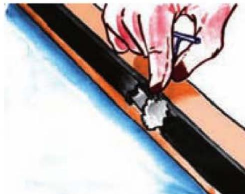
**Figura 7.68.** Aplicación de la imprimación en un trozo de cordón adhesivo.
