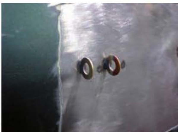
Figura 8.47. Arandelas de tracción soldadas.
