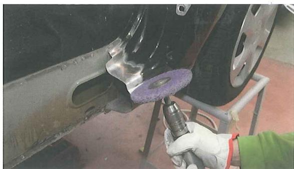
22. La misma operación se realiza con la cataforesis del recambio, facilitándose de este modo el proceso de soldadura.
