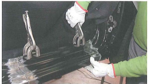
29. Para fijar el recambio se dan unos puntos MIG sobre la línea de ajuste. En este caso, la soldadura se realizará por puntos en la zona del solape, aplicando pequeños cordones discontinuos en las zonas con unión a tope.
