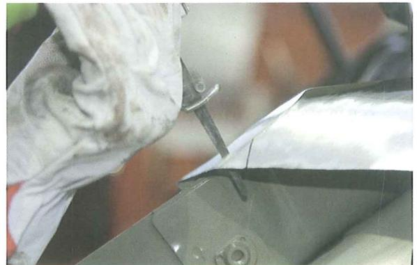
27. Con la solapadora manual, cuyo manejo es más sencillo, se realiza el solape a lo largo de la junta de unión.
