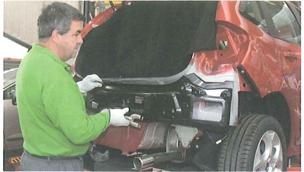
13. A lo largo del contorno del faldón se elimina la cataforesis de aquellas zonas donde se vayan a ejecutar los puntos de soldadura por resistencia, consiguiéndose, de este modo, el contacto eléctrico necesario para ejecutar la soldadura.
