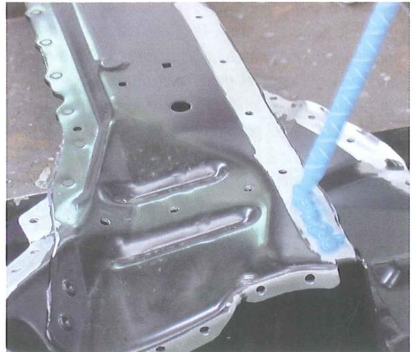
Geometría del cordón para el pegado de paneles de la carrocería.
