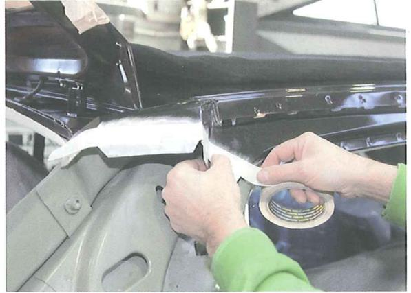
29. Se aplica una imprimación electrosoldable al cinc por la cara interna de todas las pestañas, tanto en las del solape como en las del contorno y de la pieza de recambio. De esta manera, se evitarán problemas de corrosión ante posibles filtraciones de humedad.
